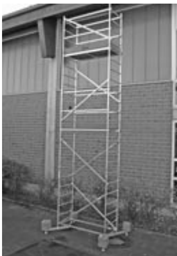
Grundgerüst mit erster und zweiter Aufstockung
