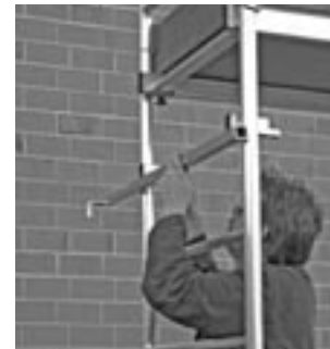
Grundgerüst mit erster und zweiter Aufstockung
